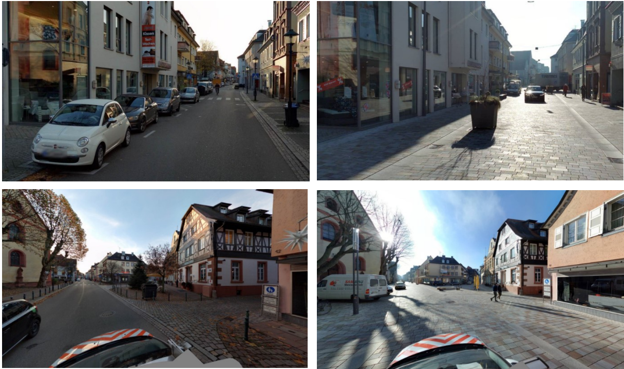
Abbildung 1: Lange Straße vor und nach dem Umbau
