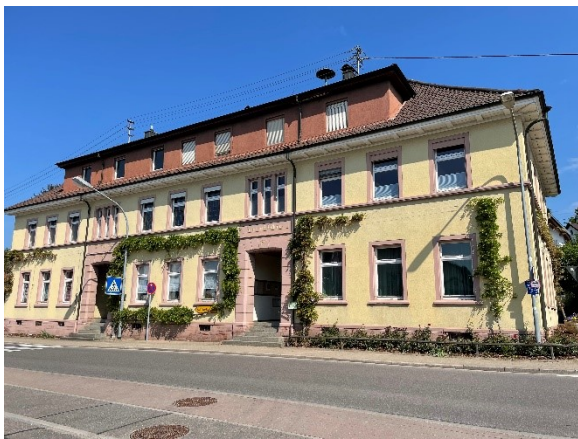
Bestandsgebäude Rathaus Rammersweier
