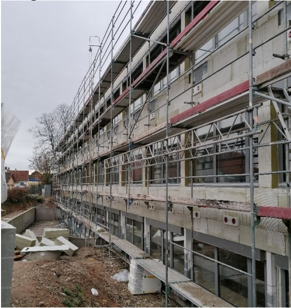
Ansicht Bauteil B – Herstellung Ostfassade
