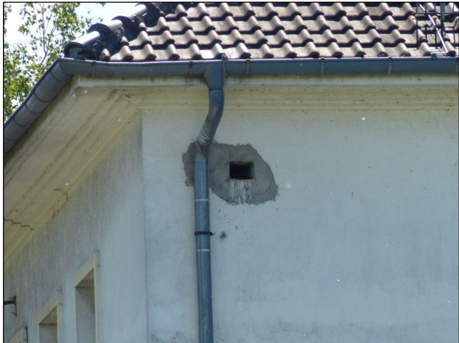
Brutplatz des Turmfal- kenpaares an einem Gebäude südlich der Teilfläche 1
