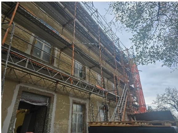
Ansicht Südwesten – Fassadenarbeiten
