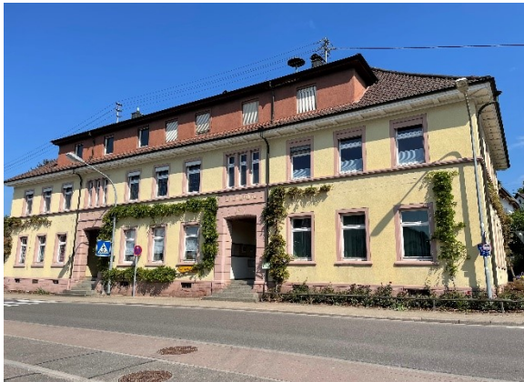
Bestandsgebäude Rathaus Rammersweiler
