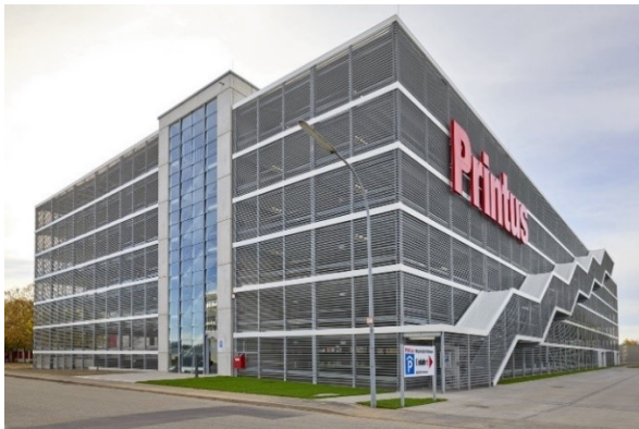
Neubau Parkhaus Fa. Printus im Industriegebiet Elgersweiler (Foto: Printus GmbH)
