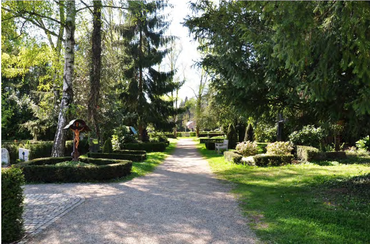
Abb. 83: Ansicht Wegeausbildung mit wassergebundener Decke ohne Randabschluss. Seitlich des Weges bestehen Reste der Birkenreihen. Ansicht von Osten mit Blick auf die Kapelle. (Bildquelle: David)
