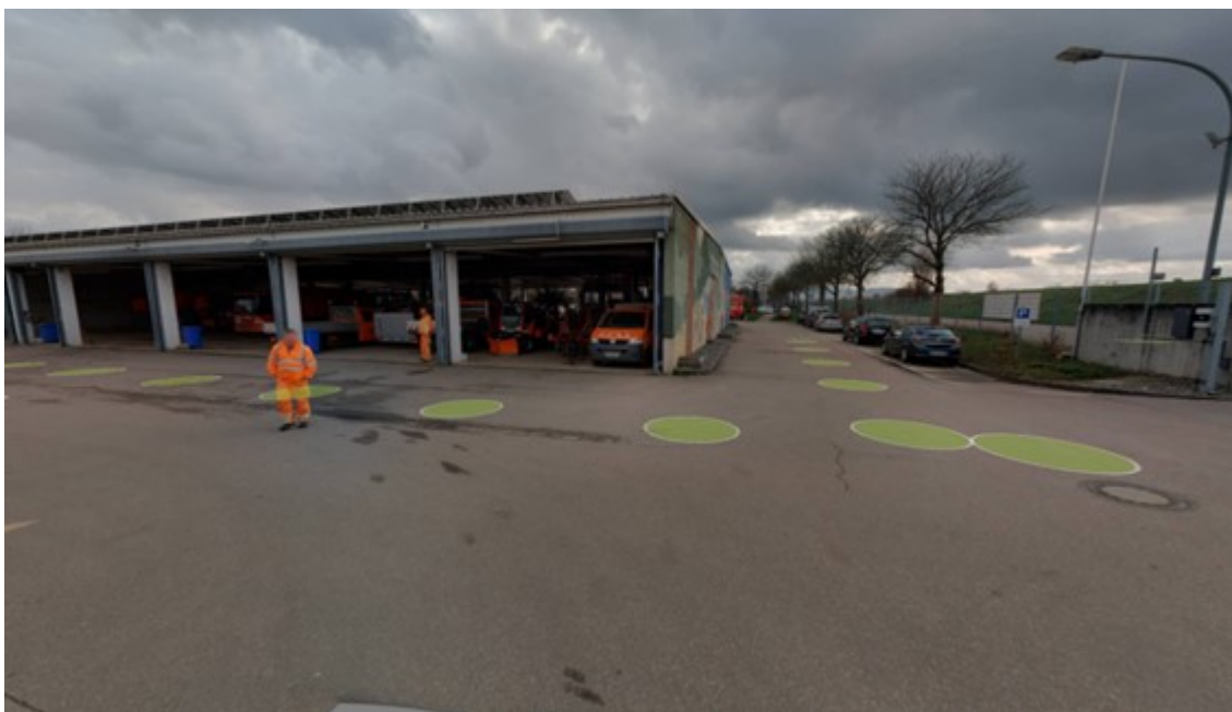
Blick von innerhalb des TBO-Geländes aus in Richtung Durchfahrt hinter die Halle:
