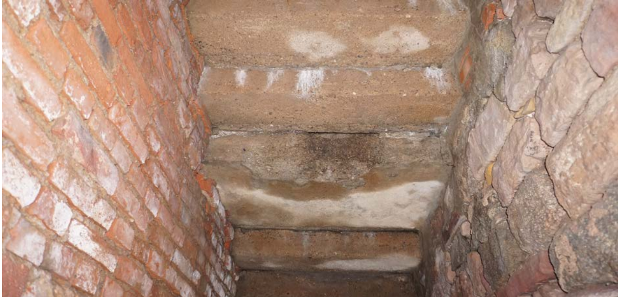
Bild 2 – Bautzeitliche Treppenstufen von unten
