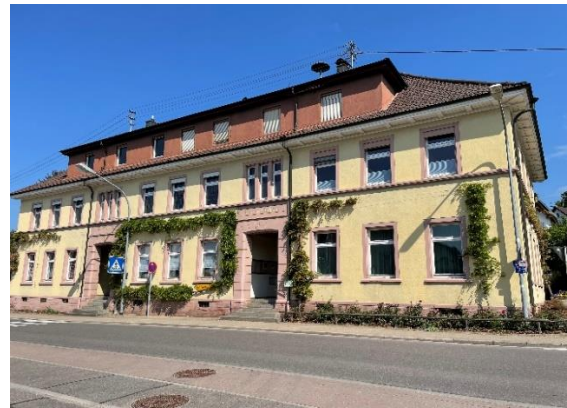
Bestandsgebäude Rathaus Rammersweier
