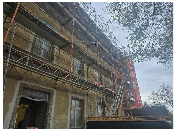
Ansicht Südwesten – Fassadenarbeiten
