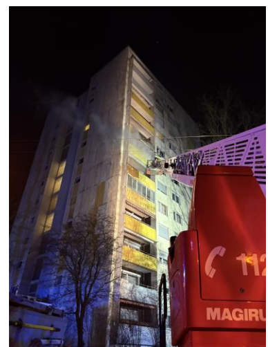
01.01.2025 | Brand 3 | Gebäudebrand – Hochhaus | OG / Bohlsbach | Bühlerfeldstr. 11
